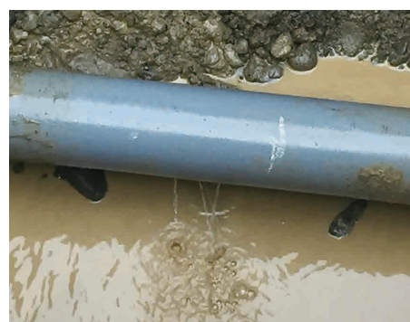
▲実際に発見した漏水箇所 (PVC管φ100mm)
